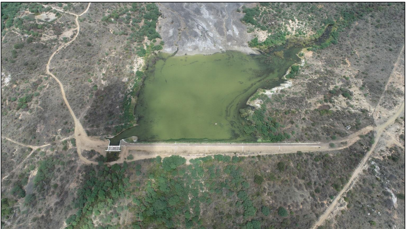
Figura 5.6 – Dique 3. Fonte: ERO BRASIL Caraíba, 2022.
