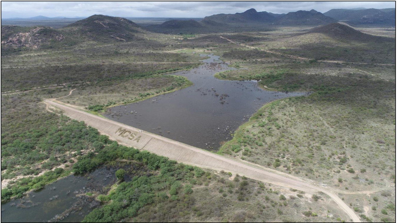
Figura 5.3 – Dique A. Fonte: ERO BRASIL Caraíba, 2022.
