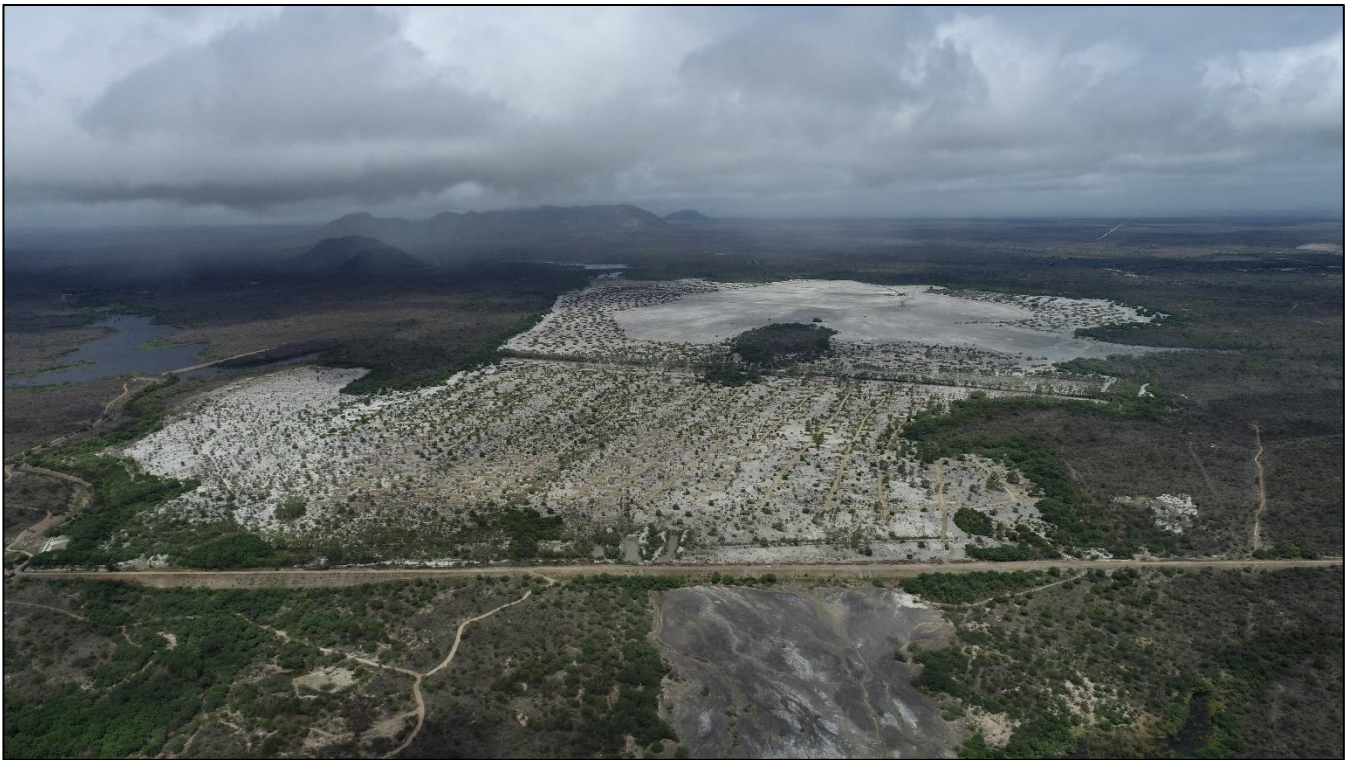
Figura 5.5 – Dique 2/2A. Fonte: ERO BRASIL Caraíba, 2022.
